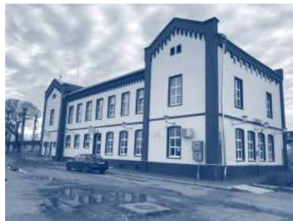
Figură 46 - Gara Orăștie Sursa: Fotografie realizată de consultant
