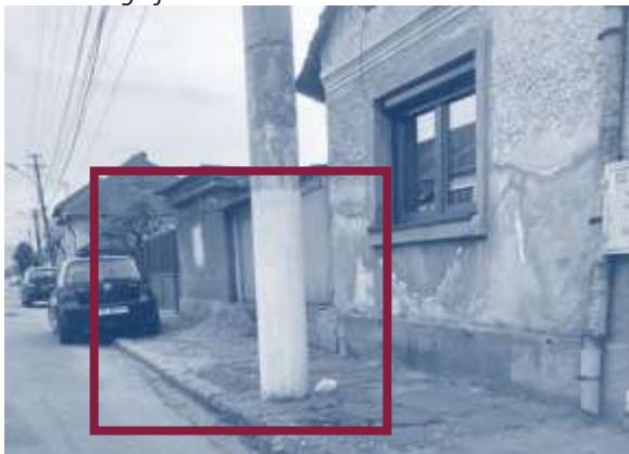
Figură 61 - Obstacole pe spațiul pietonal din Mun. Orăștie Sursa: Fotografie realizată de consultant
