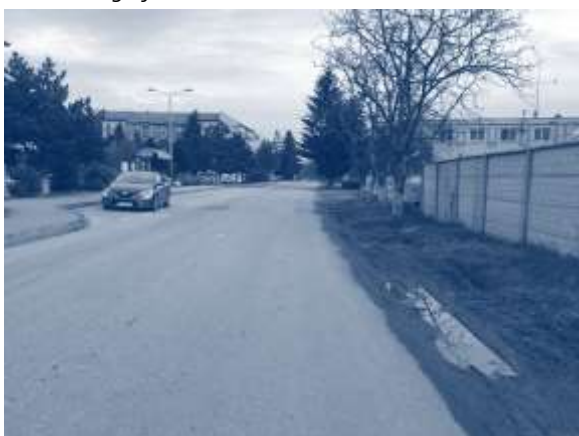
Figură 62 - Strada Pricazului - lipsa spațiului pietonal în zona de est a străzii Sursa: Fotografie realizată de consultant
